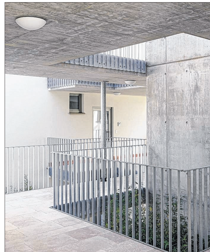
Bei der Gestaltung des Laubengangs, der die Gebäudeteile verbindet, setzt man auf Sichtbeton, Stahl und Bambus.
