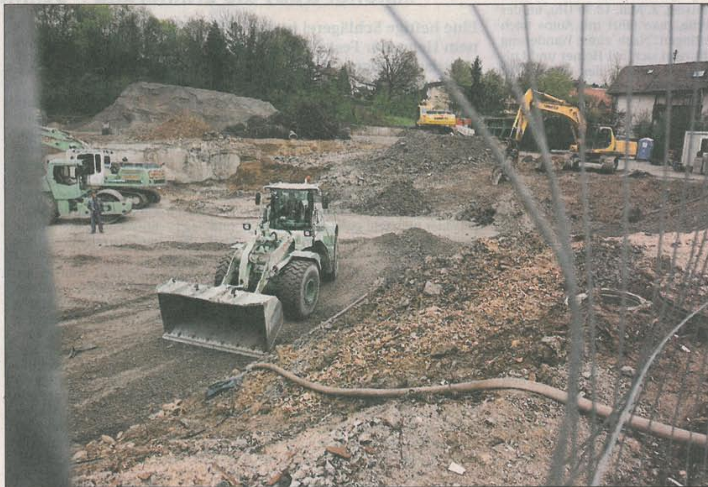
Die Abbrucharbeiten auf dem Baldauf-Areal sind fast abgeschlossen.
