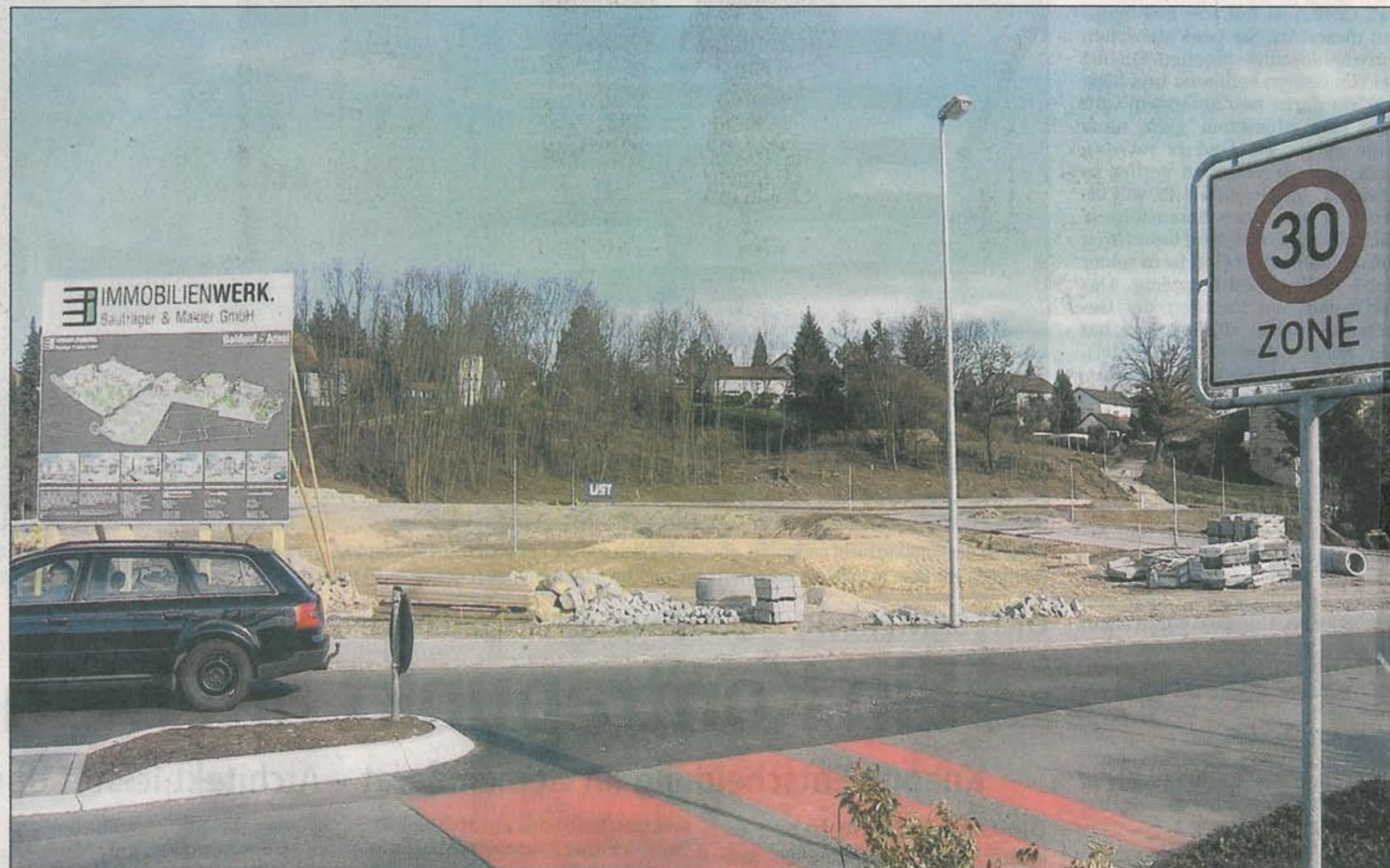
Das Baldauf-Areal ist im Moment wie leergefegt, aber bald rücken die Bagger wieder an.
