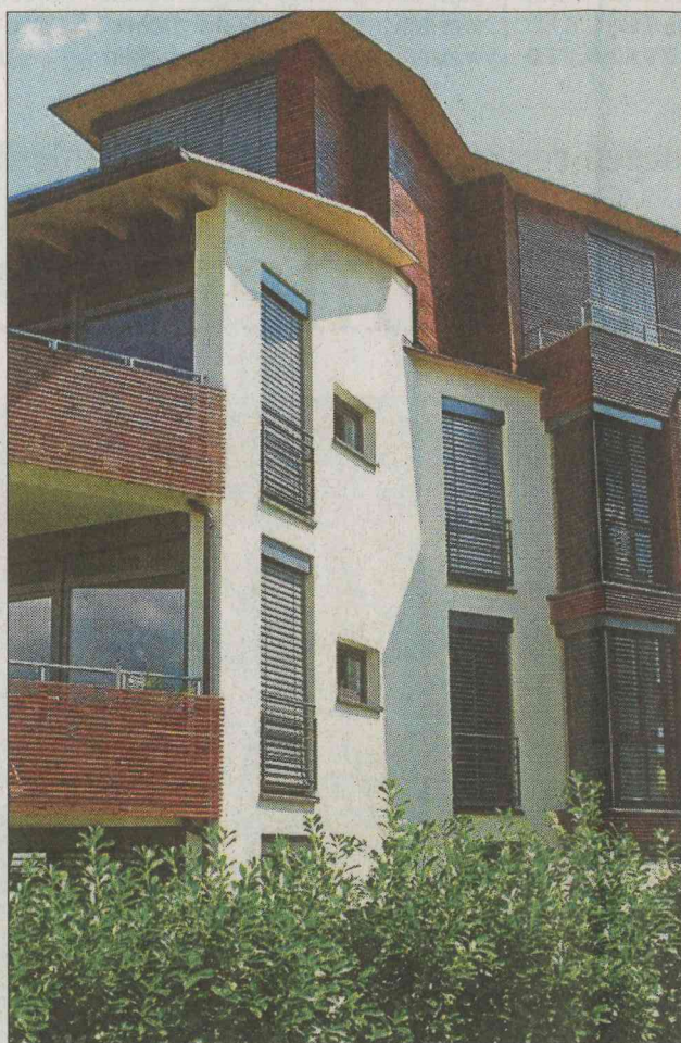
Typisch für den Baustil der Firma Immobilienwerk in Metz-ingen sind hier die Elemente aus Lärchenholz.
